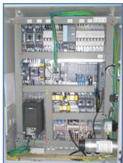
Deux IHM de conduite local et un IHM de conduite et paramétrage distant 15" (paramètre de fonctionnement et pannes) terminal **SIEMENS® S7 1500** graphique et tactile. Liaison Ethernet permettent de piloter les installations à distance à partir d'un PC (IE).
